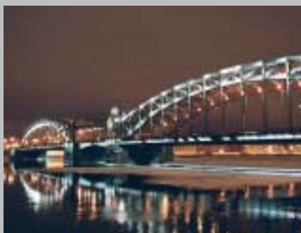
10. Большеохтинский мост. Санкт-Петербург Вадим Корчагин, ООО «УНИВЕР МЕНЕДЖМЕНТ» ИГ «УНИВЕР»
