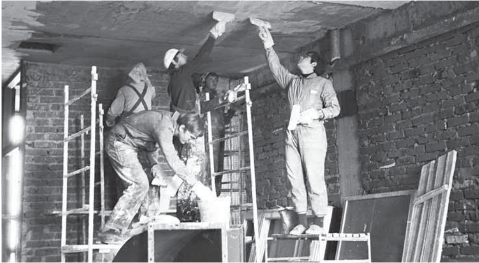
Бригада МЭО за ремонтными работами. Б.Г. Фёдоров на снимке слева. Москва, 1977 г.
